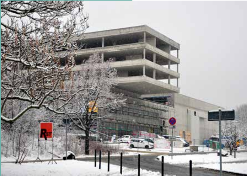
Rohbau des Institutsgebäudes im Februar 2012. Skeleton of the new building in February 2012.
