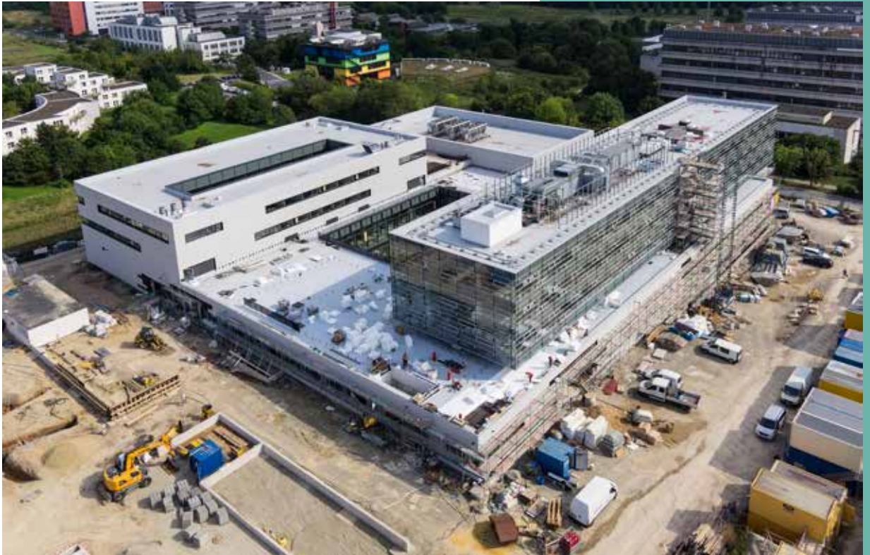
Blick aus der Luft auf die Baustelle im August 2013. A bird's eye view of the construction site in August 2013.
